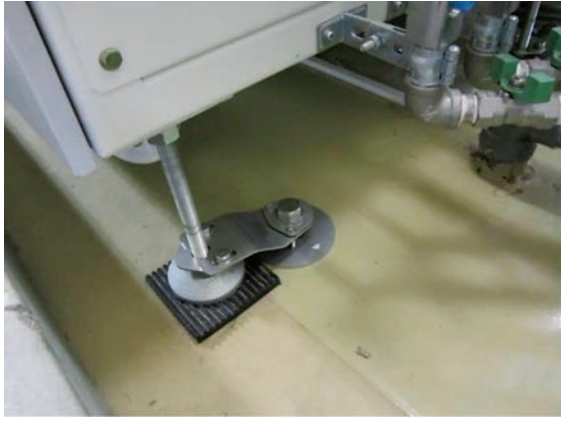
写真1 アンカーボルトの固定
