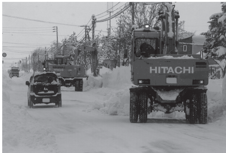
図5 岩見沢市内の車道の除雪状況
