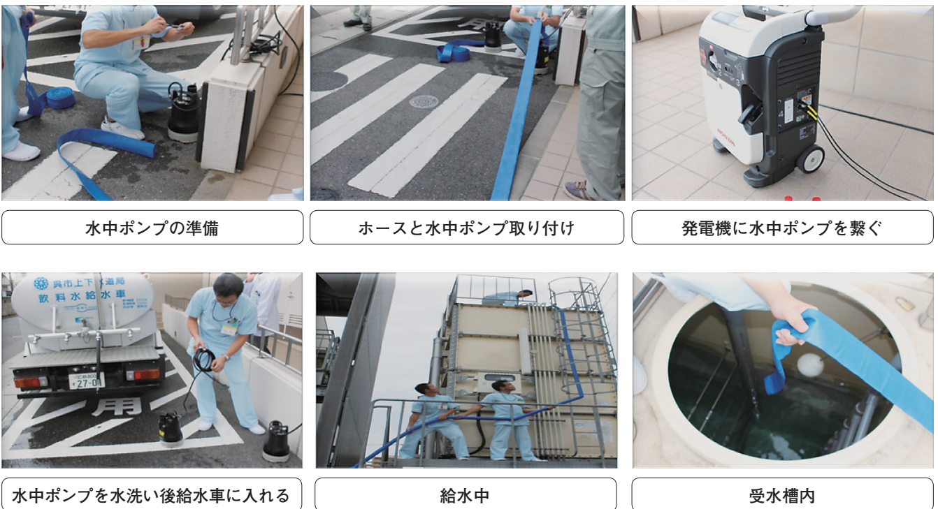
図 2 呉市上下水道局との訓練風景（2016 年 10 月）
