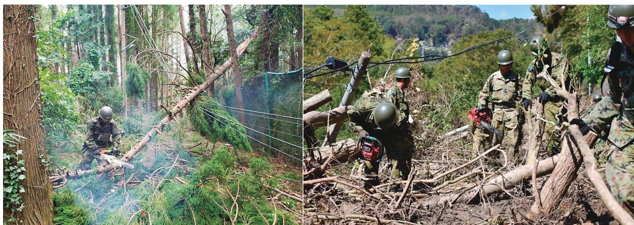
図 10 房総半島における自衛隊の送電網復旧作業 (陸上自衛隊 東部方面隊 @JGSDF_EA_PR)
