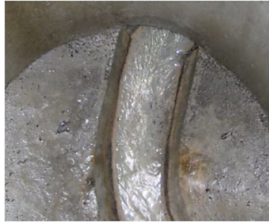
通常の汚水管
